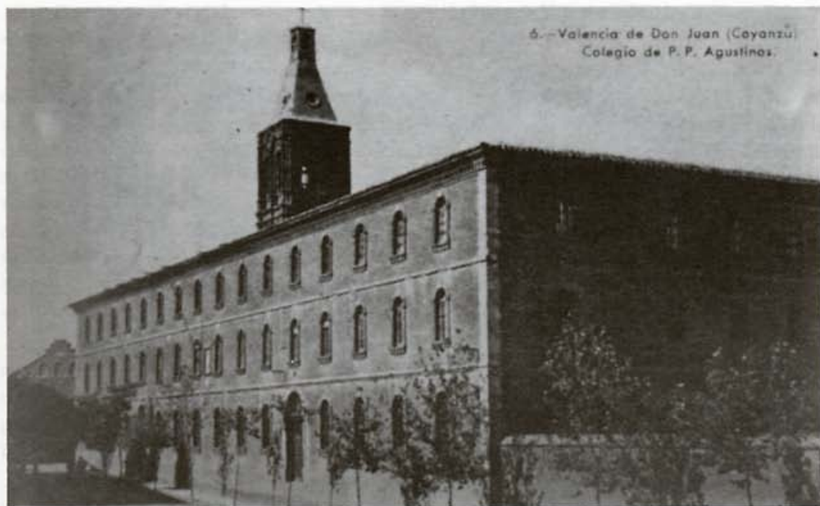
Fachada del Colegio de P.P. Agustinos, que recientemente ha sido demolido entre el 2 y 5 de junio de 1992.
