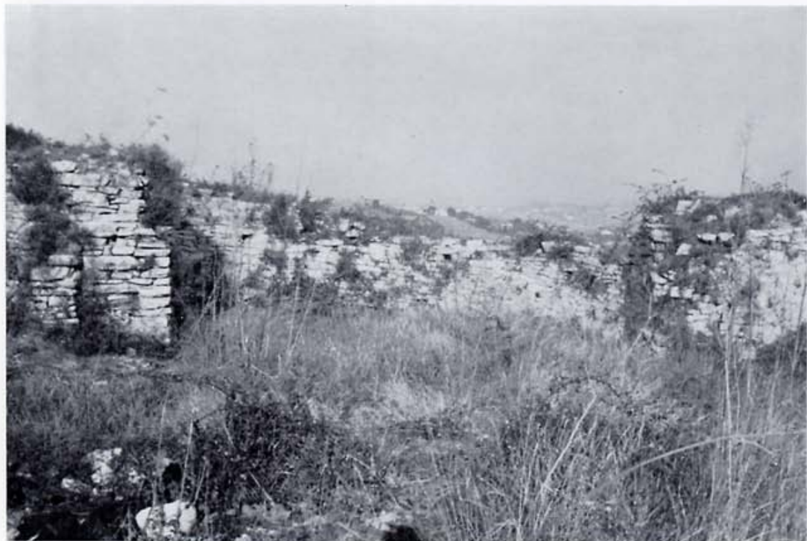
Fig. 8. San Pedro de Veranes (Gijón), detalle del interior del ábside.
