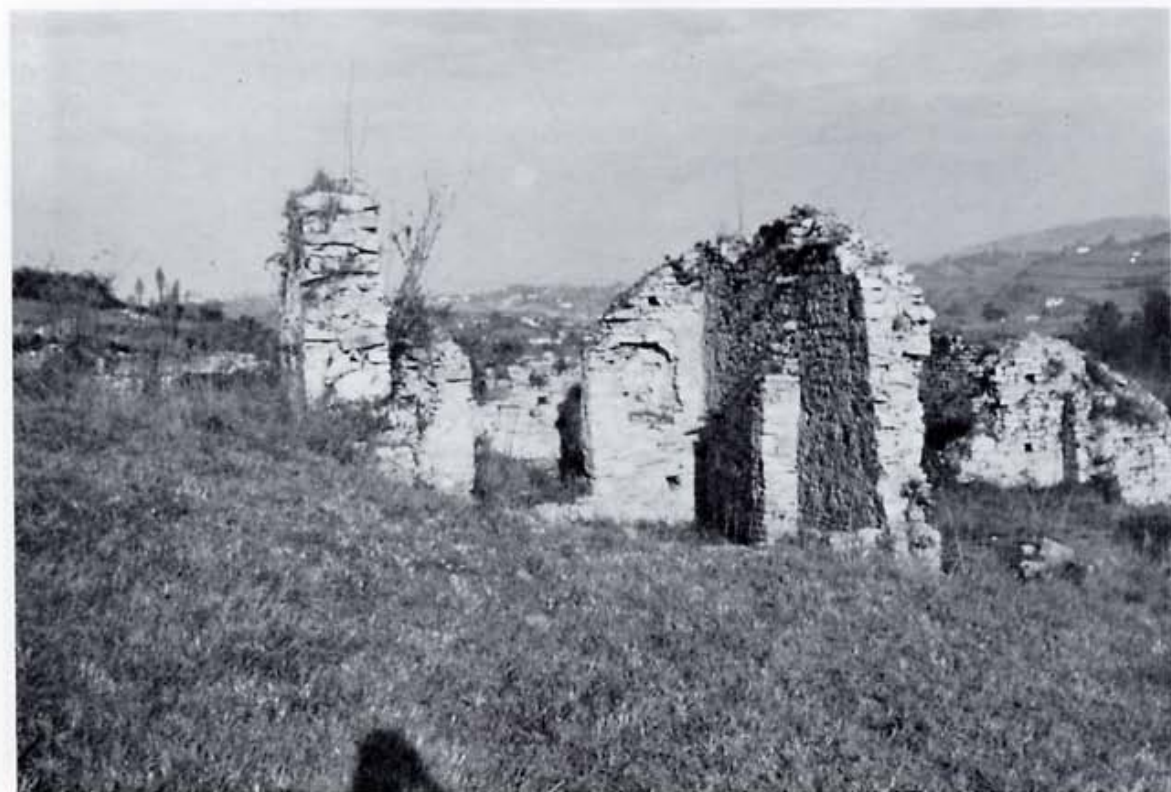
Fig. 9. San Pedro en Veranes (Gijón), edificaciones anexas.
