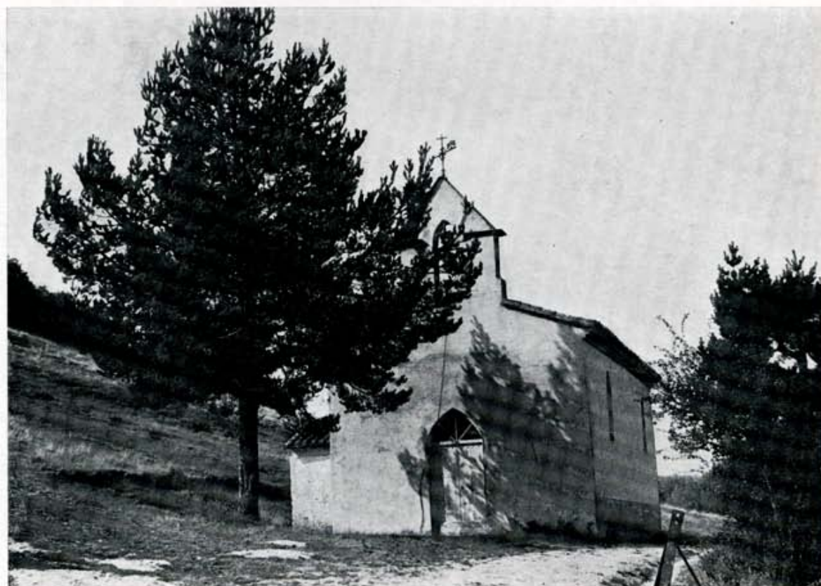
Ariego de Abajo: Un modesto ejemplo de rehabilitación cultural.
