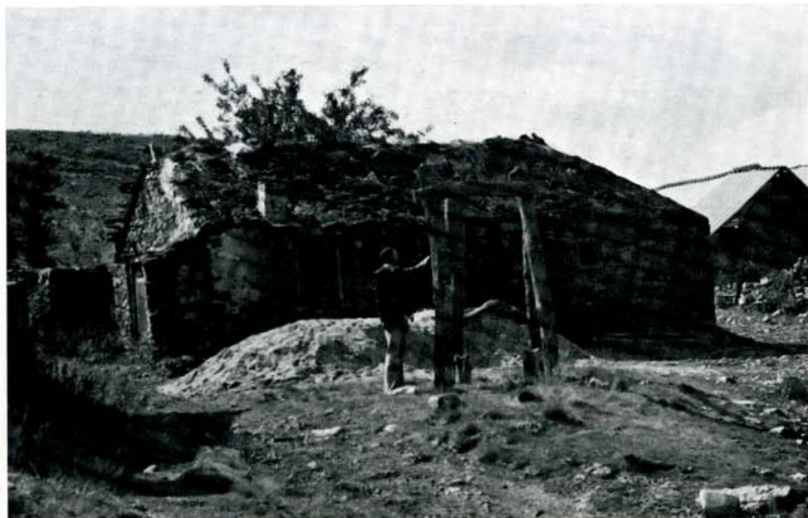
Murias de Ponjos: Arquitectura popular degradada.
