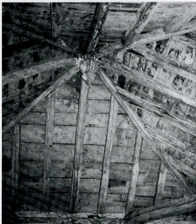
Bóveda de la ermita.
