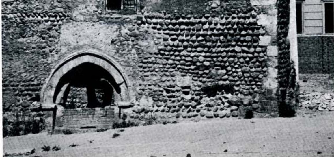
Muro del poniente construido a cal y canto, típico de León, con sillares en las esquinas. En la planta baja se aprecia una puerta proto-gótica con arco ojival de dos arquivoltas, impostas y moldura externa. Actualmente se contempla entera, por haberse bajado el nivel del suelo.
